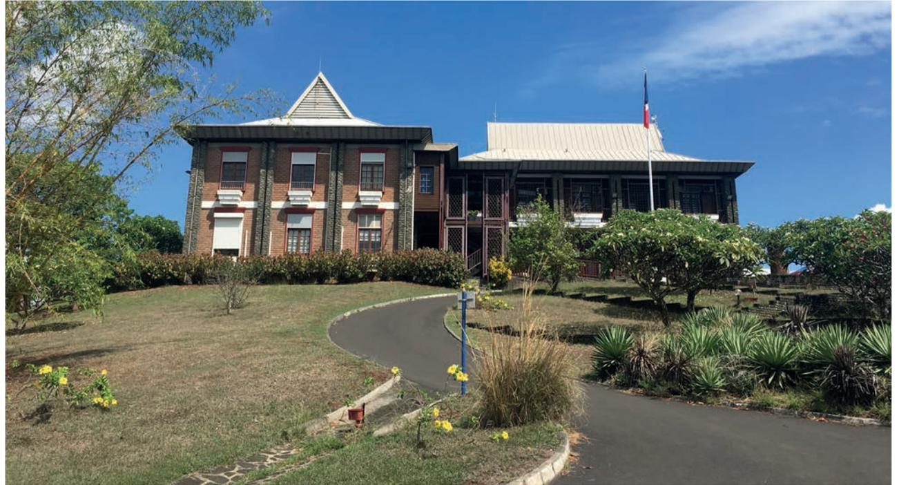
La conception des bâtiments favorise la ventilation naturelle, par la généralisation des doubles toitures ou des combles ventilés, les galeries sur les faces exposées au soleil, les grands débords de toiture, des niveaux plus amples en hauteur...
