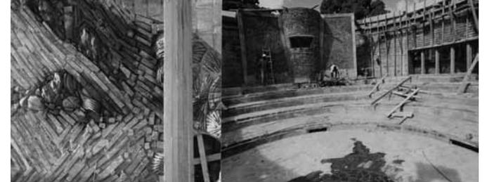
Les matériaux locaux sont mis en oeuvre brute. La qualité de réalisation est soignée, précise, le mur doit être beau par lui-même. les pierres sont extraites de différentes carrières en fonction des besoins (dallage, mosaïque, opus, murs). Les artisans initiés à la préfabrication de chantier réalisent des poteaux, des chaînages, des coques comme sur le minaret de Tsingoni.
